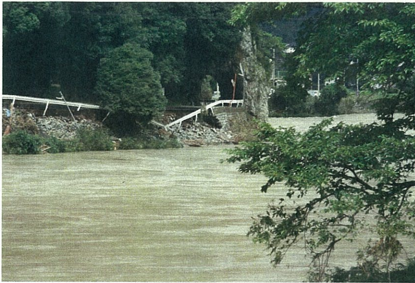
山崎町田井 洞門下流側
