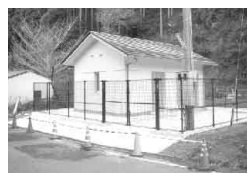
原導水ポンプ所
