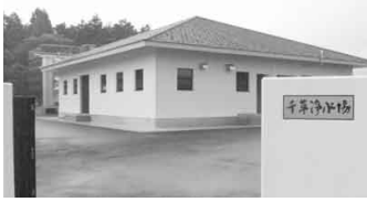
過疎対策事業 （簡易水道再編推進事業：千草浄水場）
