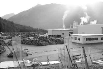
稼働を開始した兵庫木材センター
