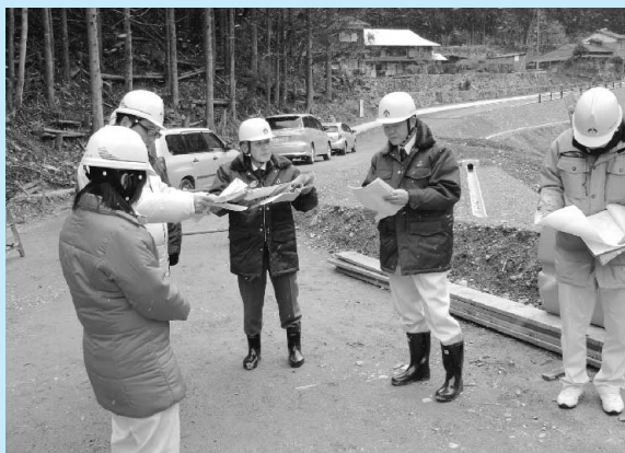
市道西二連瀬線工事監査
