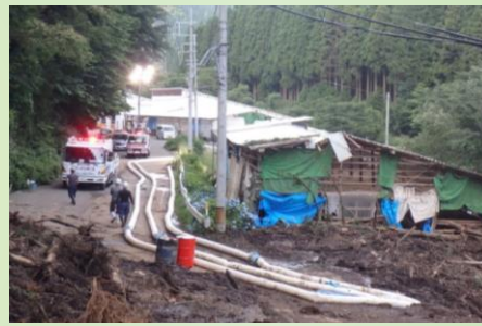
【排水ポンプ車による 土砂ダム滞留水の排水作業】
