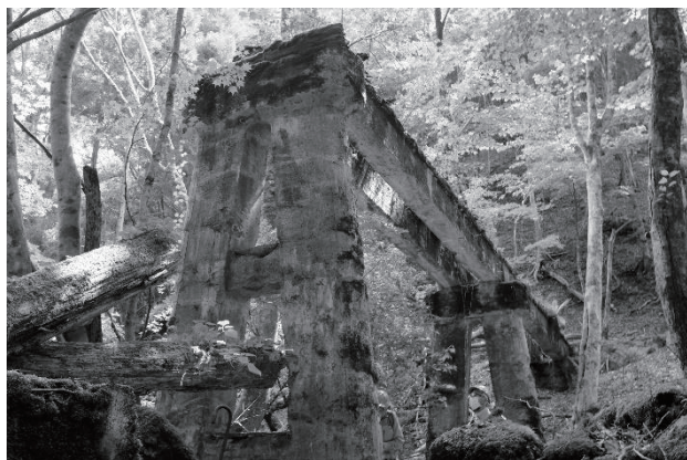
写真 1 中音水線第 10 橋梁（2022 年 6 月 1 日）
