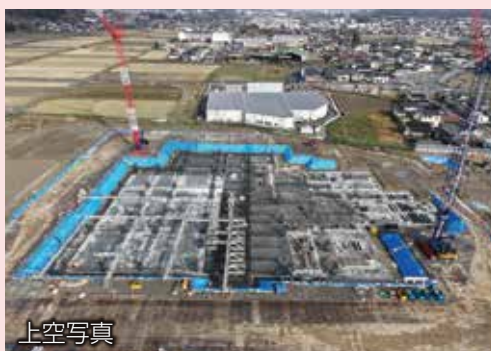
鉄筋組立作業
