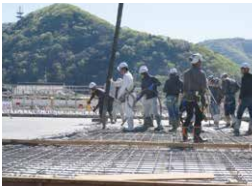
1階床スラブ施工状況
