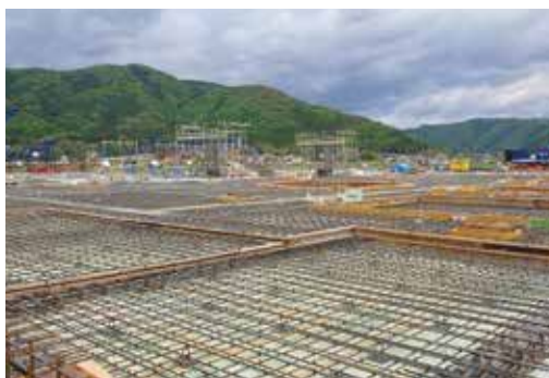
1階床スラブ施工状況
