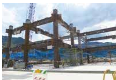
鉄骨工事施工状況
