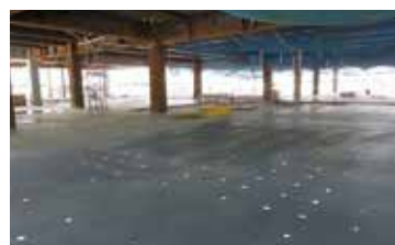
2階床コンクリート施工写真
