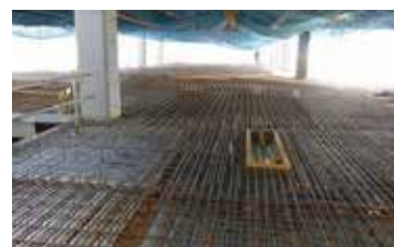
躯体工事 施工写真
