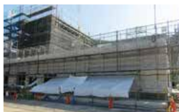
外装工事 施工写真
