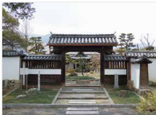
平成23年度に修復を行った山崎陣屋の紙屋門
