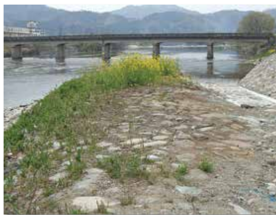
修復後の船着場石出し
