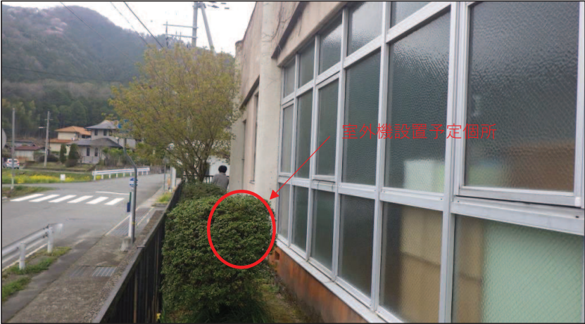
ステージ北面屋外状況
