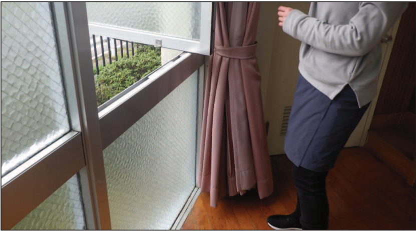
設置予定箇所ガラス状況
