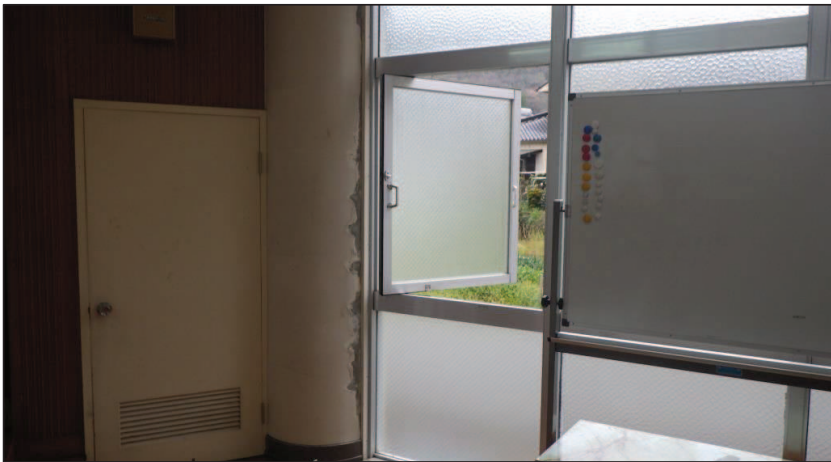
設置予定箇所ガラス状況
