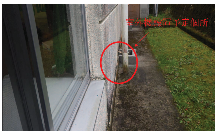
ステージ北面屋外状況
