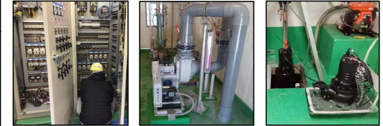
西河内地区処理施設 機器更新工事
