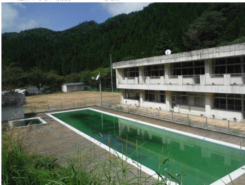
▼旧道谷小学校（南側 プールと校庭）
