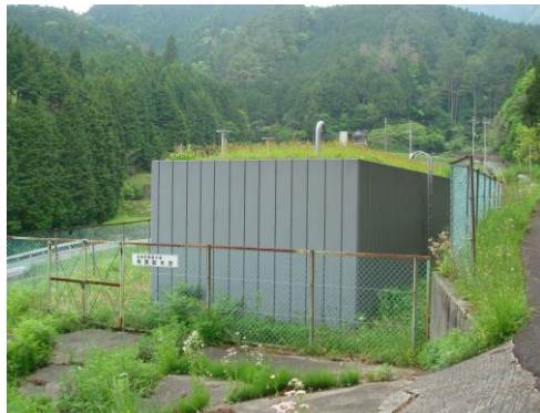
有賀配水池（昭和53年竣工・波賀町有賀）
