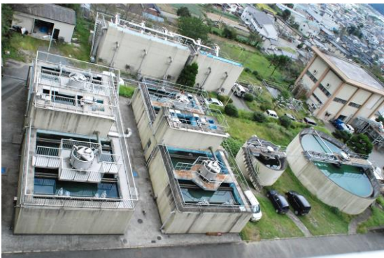
上寺浄水場空撮（山崎町上寺）
