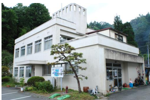
管理棟事務所
