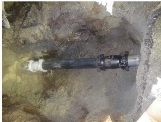
破断した塩化ビニル管の取り替え（波賀町上野）
