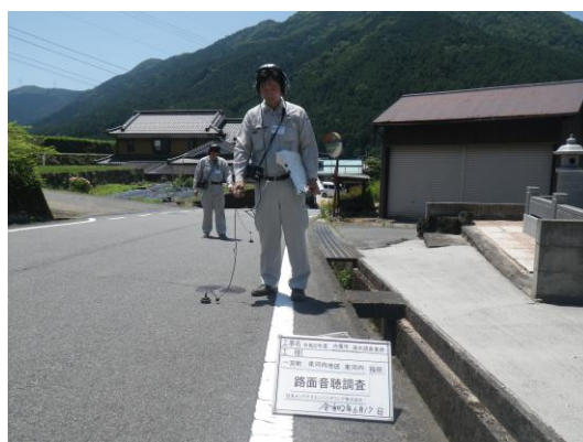
漏水調査実施の様子
