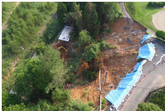
法面崩壊によって土砂が流入した内海第2配水池（千種町岩野辺）
