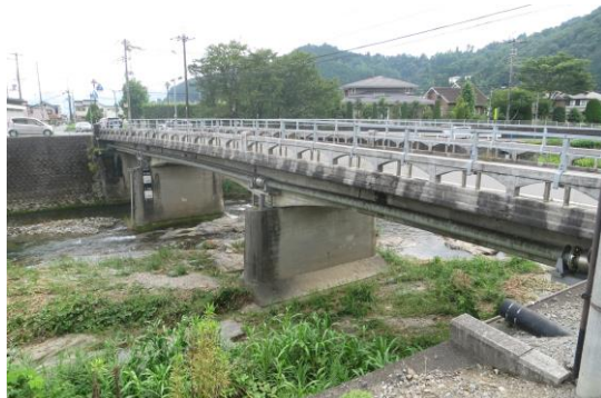
生谷橋（山崎町生谷）
