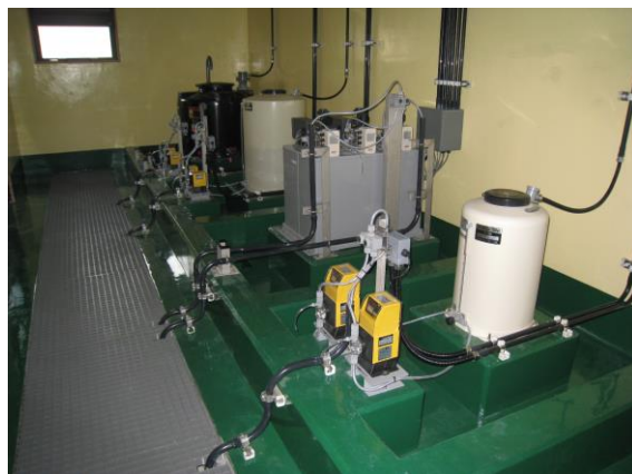
千草浄水場の計測機器・薬品注入設備（千種町）
