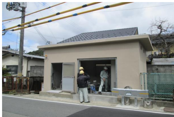
須賀沢第1加圧ポンプ場（山崎町須賀沢）
