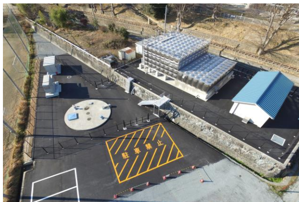
中井水源（山崎町中井）
