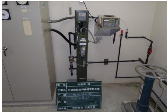
残留塩素計の更新工事（鹿伏浄水場・波賀町鹿伏）
