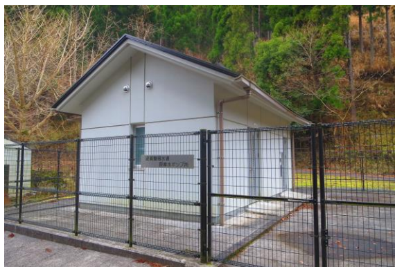
原導水ポンプ所（波賀町原）
