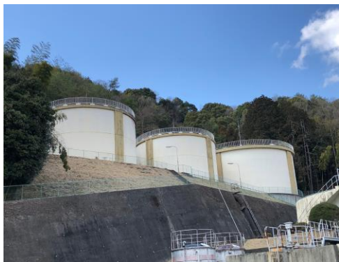
上寺配水池（昭和51年竣工・山崎町上寺）
