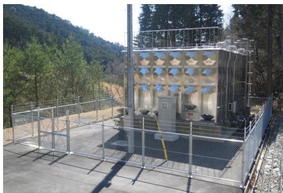
内海第2配水池
