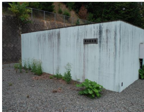
青木配水池（平成8年竣工・山崎町青木）
