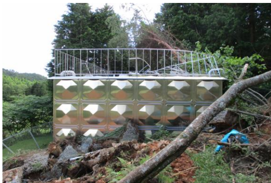
法面崩壊によって土砂が流入した内海第2配水池（千種町岩野辺）
