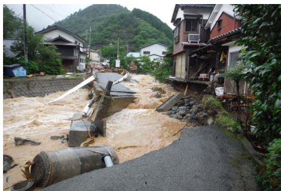
河川氾濫により落橋した樁下橋（一宮町河原田）
