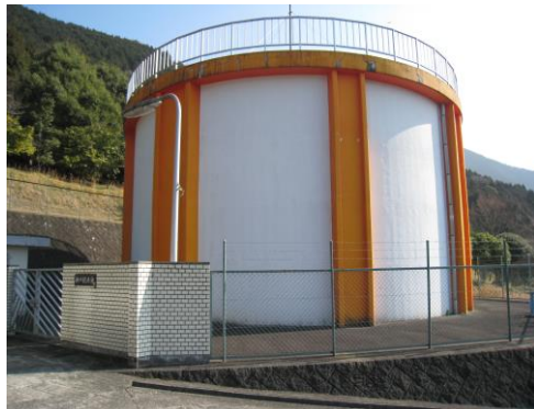
神戸配水池（平成2年竣工・一宮町東市場）
