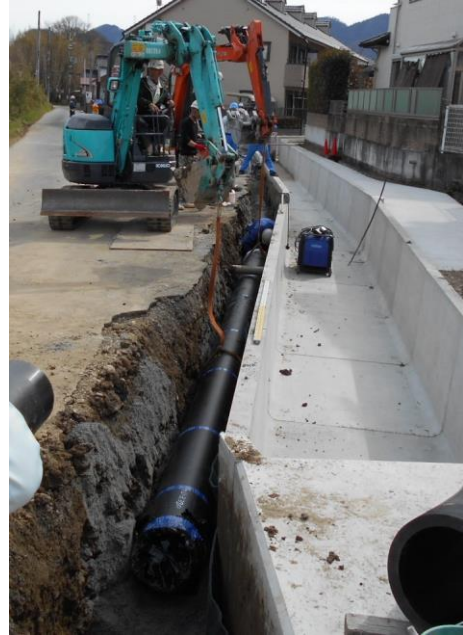
水道管更新工事の様子
