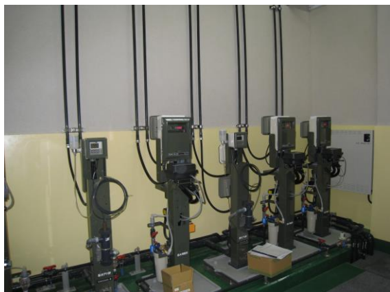
千草浄水場の計測機器・薬品注入設備（千種町）
