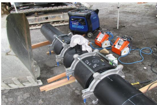
耐震性能のある水道管への更新
