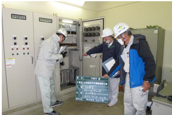
計装盤内の更新工事（草木千町浄水場・一宮町千町）
