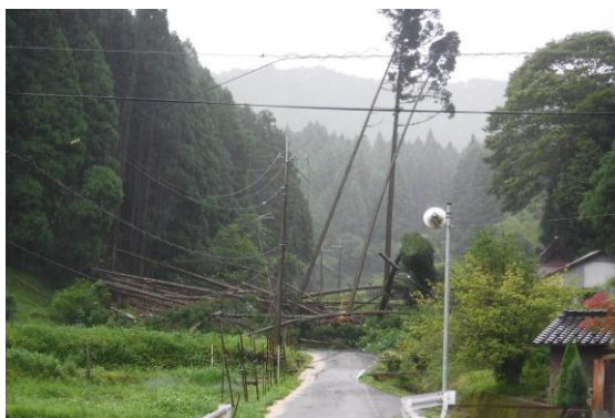
土砂の崩壊により配水管が破断（波賀町水谷）
