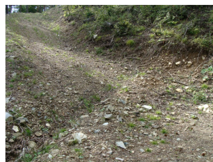
素掘りによる横断溝
