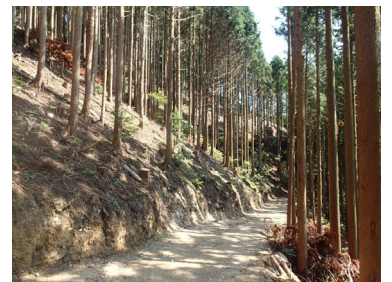
伐開幅を最小限にし 道際の木も残した作業道
