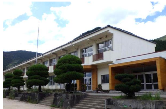
(写真 兵庫県立森林大学校 校舎)
