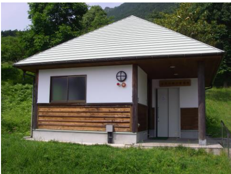
屋外公衆便所
