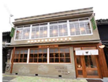
町屋を改修してオープンした店舗
