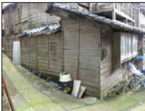
外壁が裸木造の例
