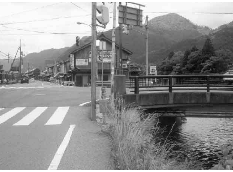
国道29号・主要地方道 養父穴粟線交差点
