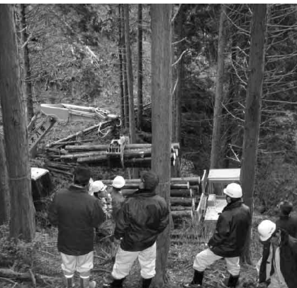
大型機械での作業風景
