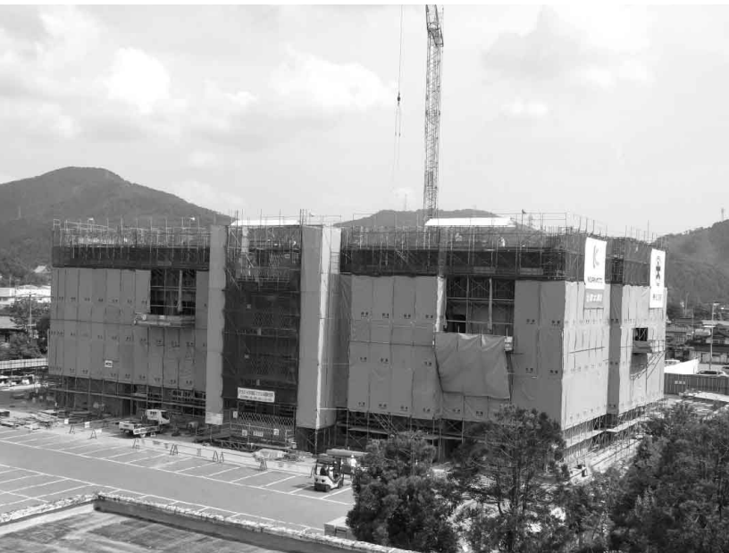
新庁舎建設現場
