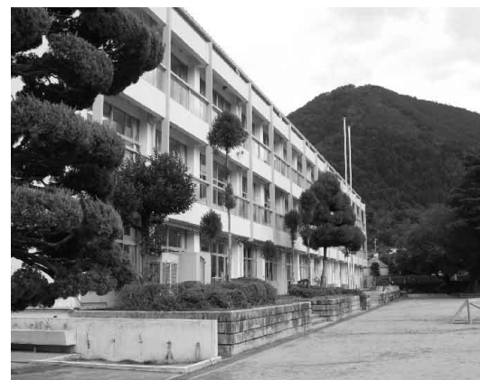
耐震化工事が完了した神戸小学校
