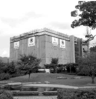
建設中の新庁舎
