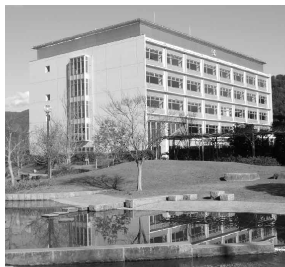
完成間近の新庁舎
