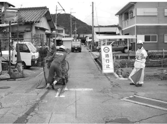
段地区の下水道工事
