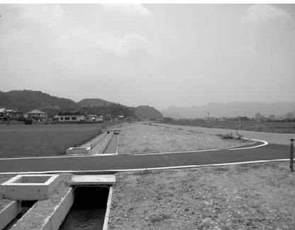
工事中の田井中広瀬線
