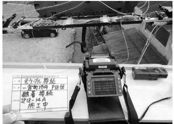
融着機により光ケーブルを接続
