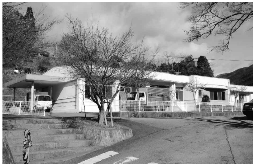
波賀学校給食センター
