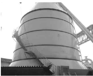
バイオマス発電施設
