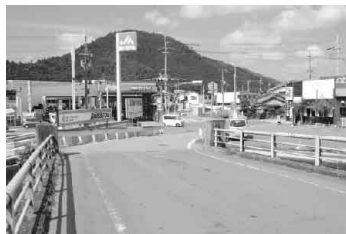
河東大橋西詰
