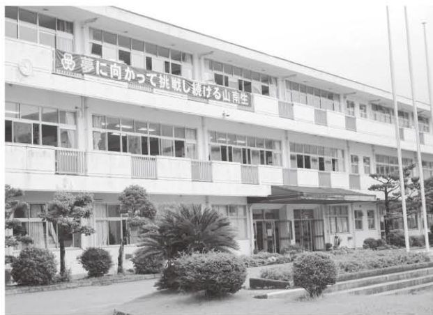
改修予定の山崎南中学校
