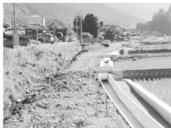
工事中の県道加美穴栗線
