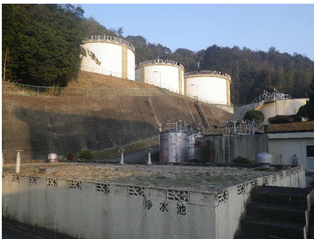
山崎町 上寺浄水場
