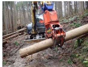
【写真1】伐倒木の移動、集積を担う機械です。斜面にある木を林道まで上げることができます。
