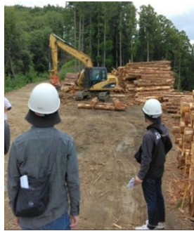
【写真3】土場の様子
