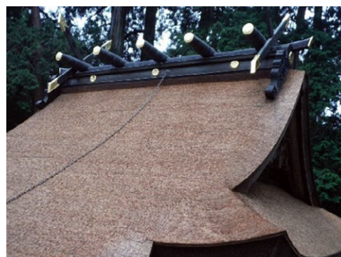
伊和神社本殿屋根葺替工事
