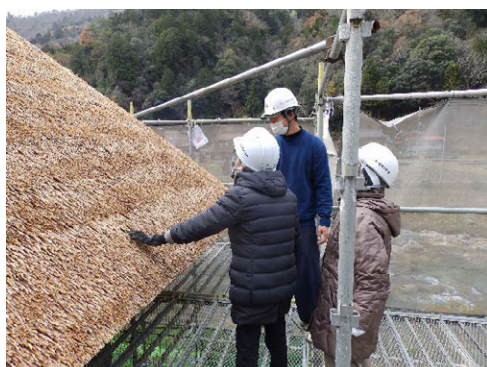
一里堂屋根改修工事説明会
