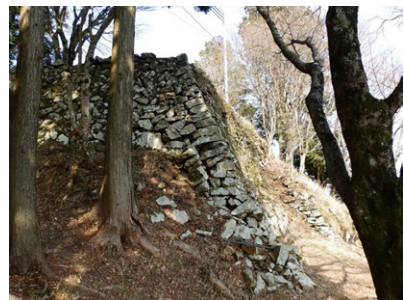
長水城跡 主郭(本丸)の石垣隅部
