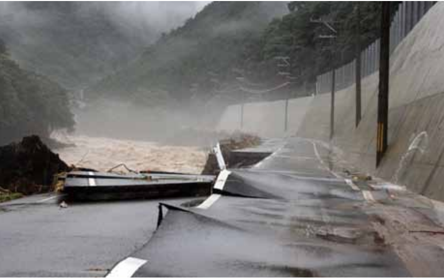
一宮町安積 道路の被害状況(主要地方道養父穴粟線)
