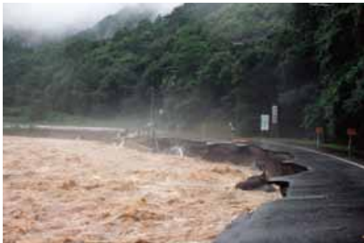
一宮町楽里地内の主要地方道 養父穴栗線と揖保川の状況
