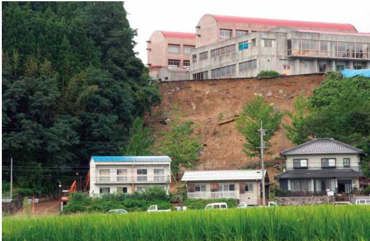
千種町河呂 千種中学校 法面崩落
