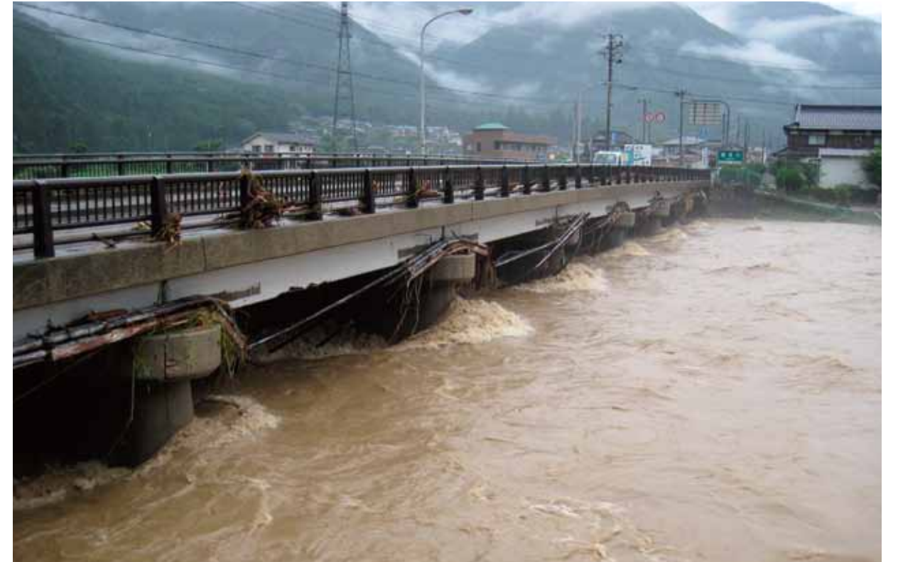
一宮町安積 国道29号曲里橋
