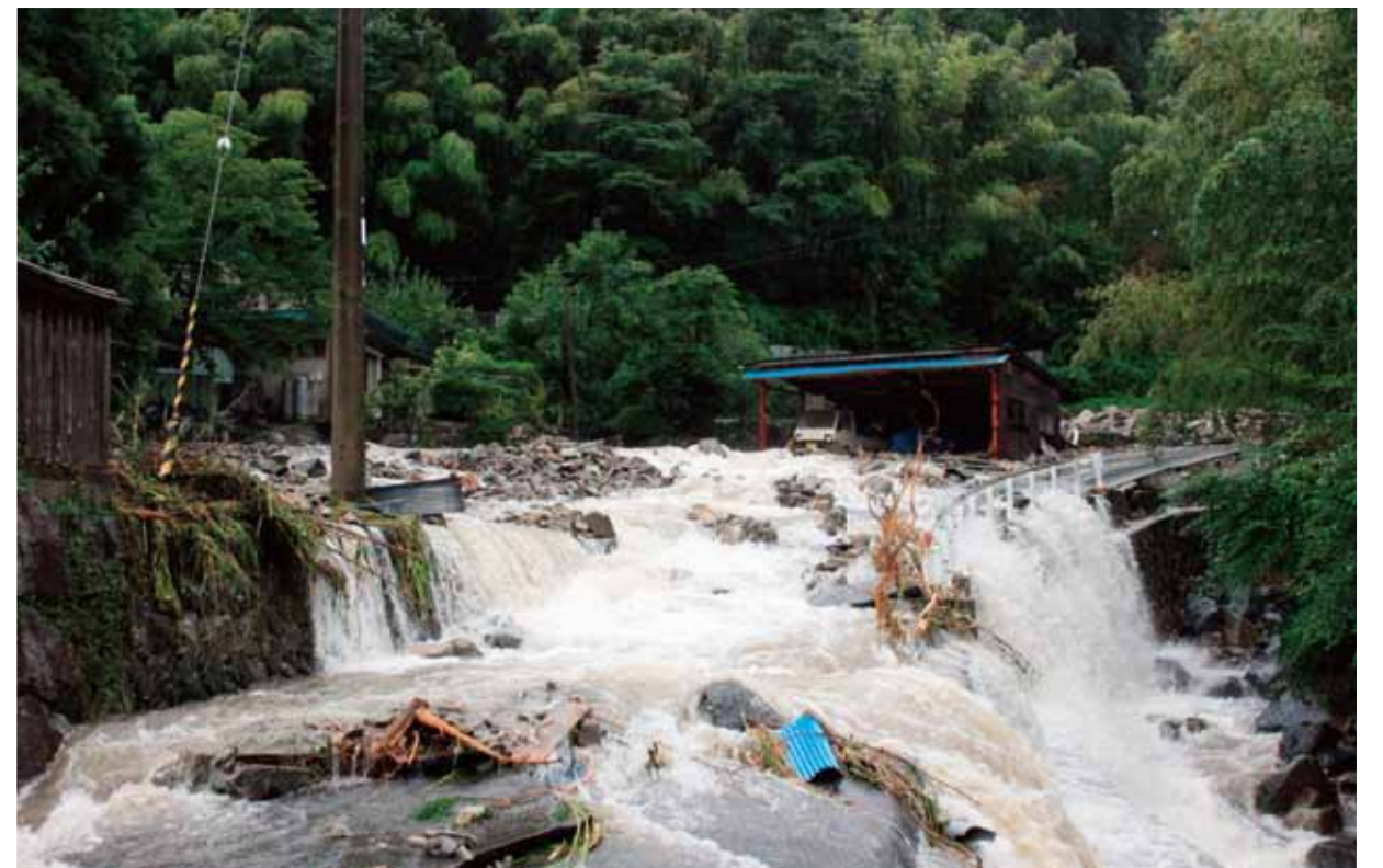
一宮町生栖 冠水した道路
