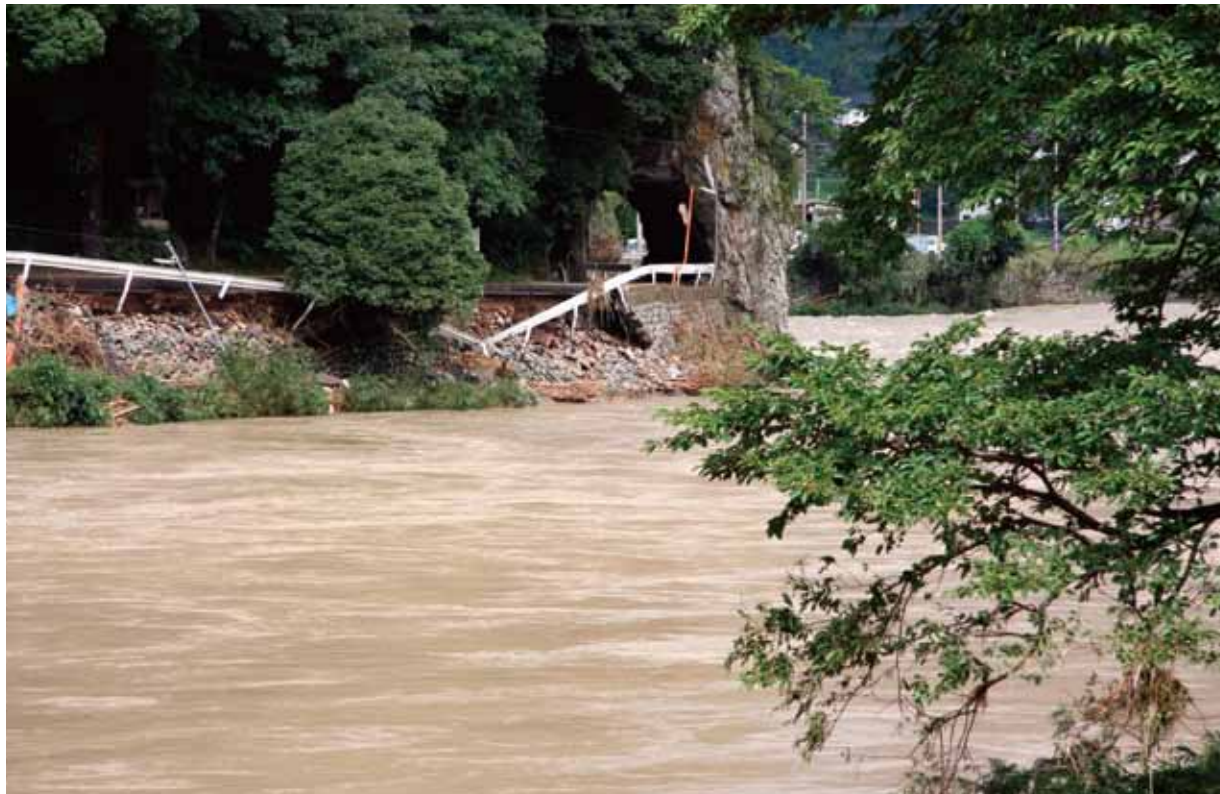
山崎町与位 与位洞門付近
