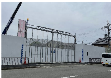
工事用ゲート（例）
