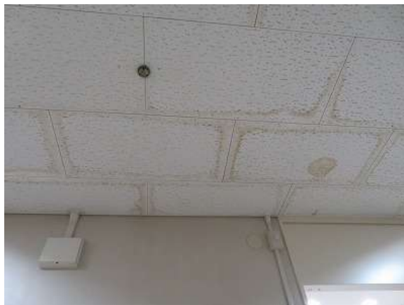
<南館5階廊下天井>
